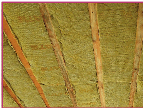
Zwischensparrendämmung
