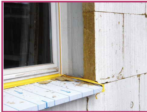
Fensteranschluss beim WDVS
