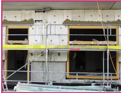
Beim WDVS werden die Dämmplatten von außen an die Fassade gedübelt.
