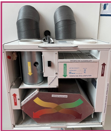
Kreuzwärmetauscher
