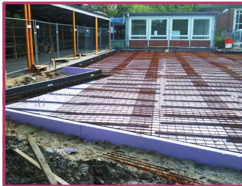
Sohlendämmung beim Neubau
