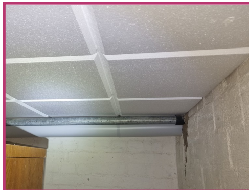
Kellerdecke nachträglich von unten gedämmt
